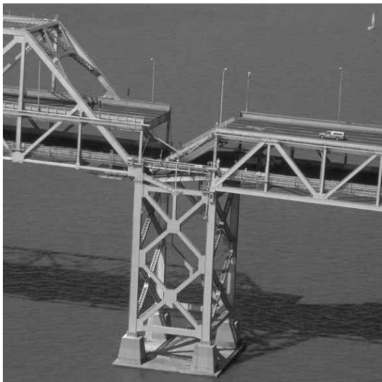
Повреден мост вследствие на земен трус магнитуд 5.7
